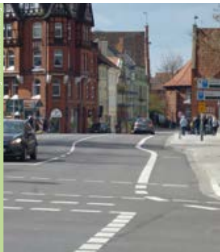
Vor dem Umbau befand sich hier ein schmaler baulicher Radweg.
